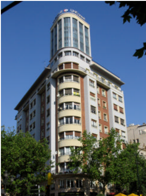
EDIFICIO DE PASEO DE PAMPLONA, 1
